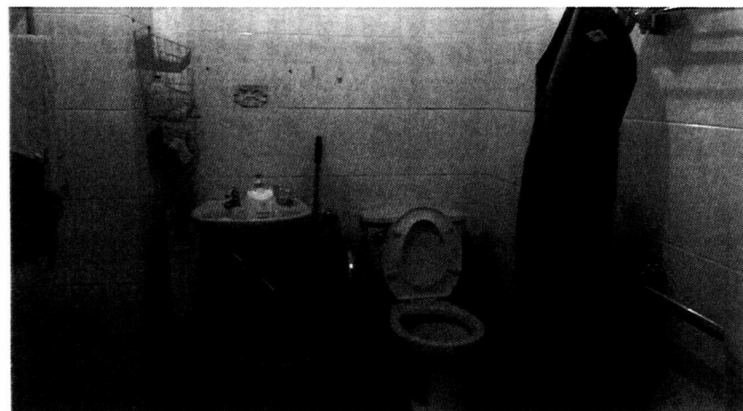
現況行動不便者浴廁照片
