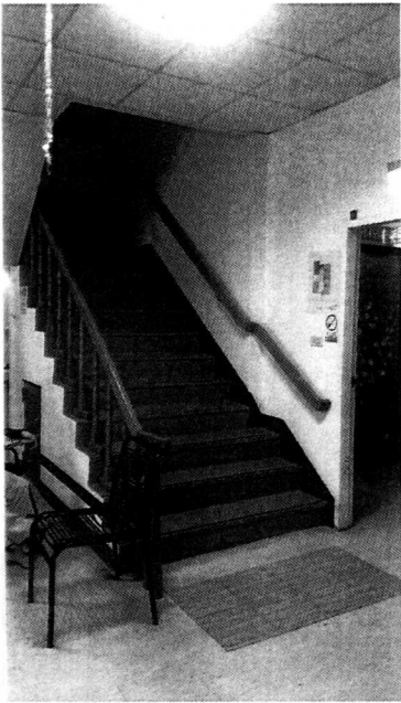
現況樓梯照片
