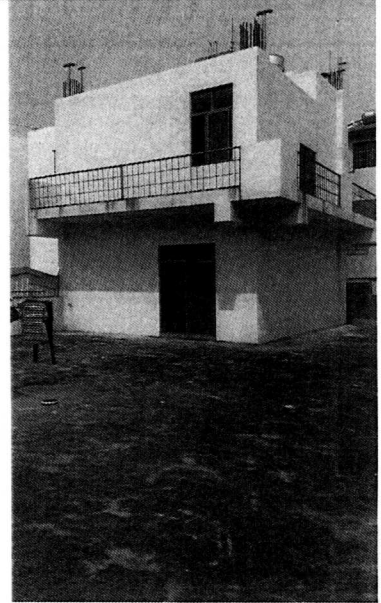
現況三樓及四樓照片
