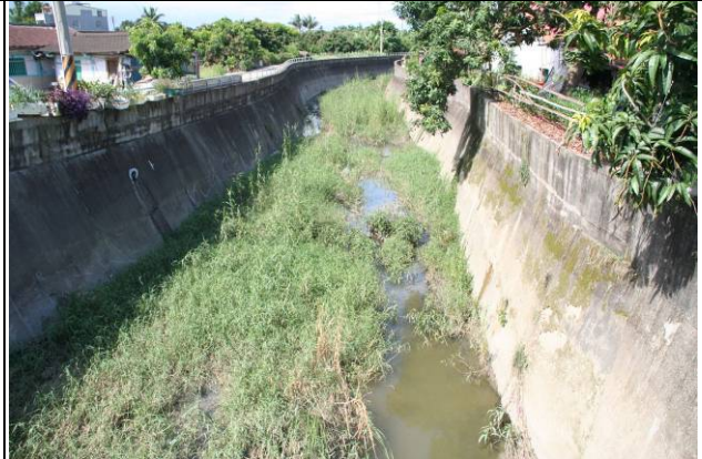
第一號橋附近環境現況
