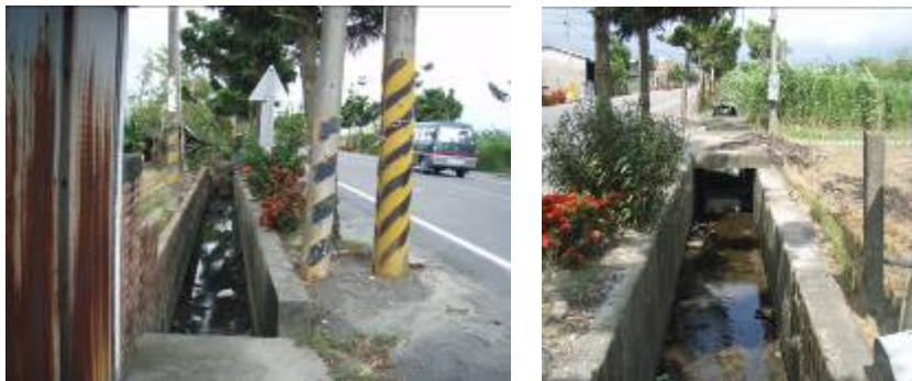
圖 11.1 重溪社區排水路
