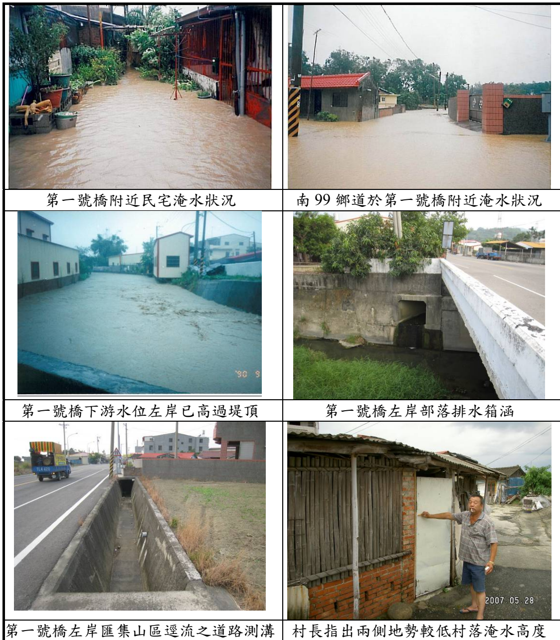
圖 3.4 東山鄉科里村第一號橋地區淹水狀況
