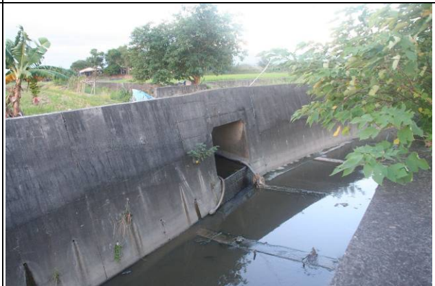
五軍營排水匯入大腳腿排水環境現況
