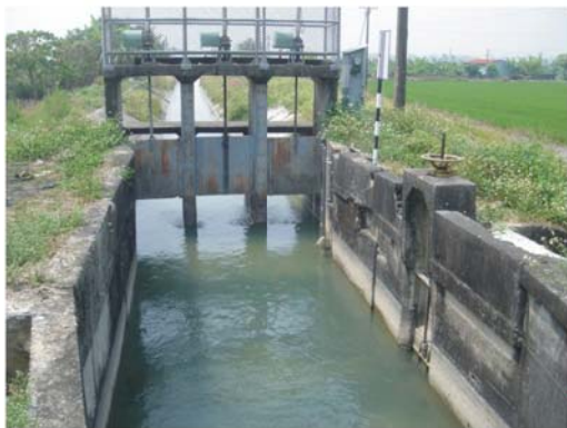
照片3-20 南幹支線水路橋，其正下方為崩溝溪排水，呈垂直貌
