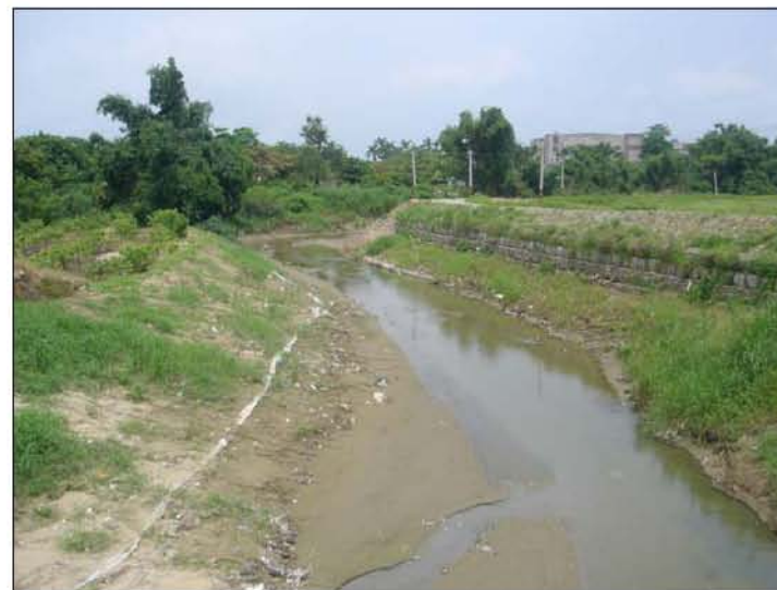
帝溪橋下游右岸竣工後現況(本計畫民國97年7月15日攝)
