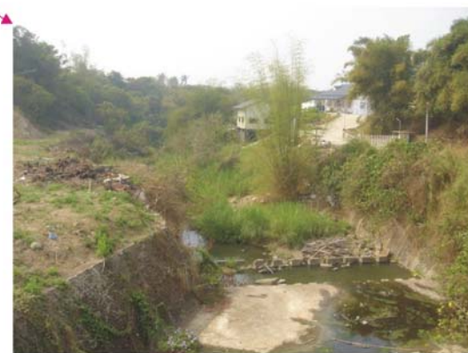
照片3-3 虎龍橋下游渠道現況
