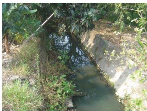
照片3-60 三舍甲橋下游現況
