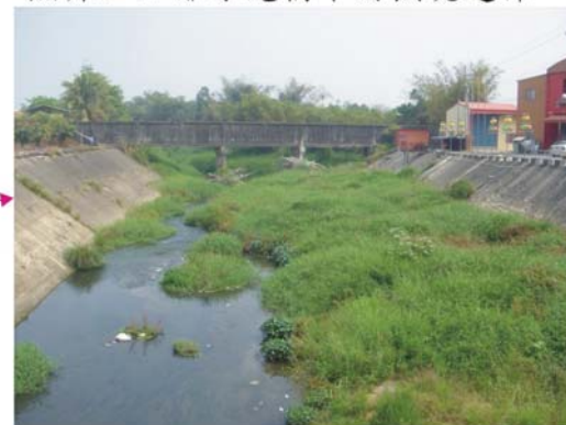
照片3-10 無名橋下游南幹支線以 水路橋方式穿越虎頭溪
