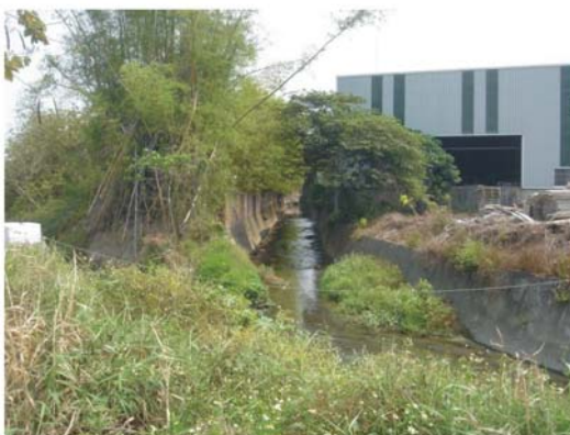
照片3-49 洋子中排一排水出口
