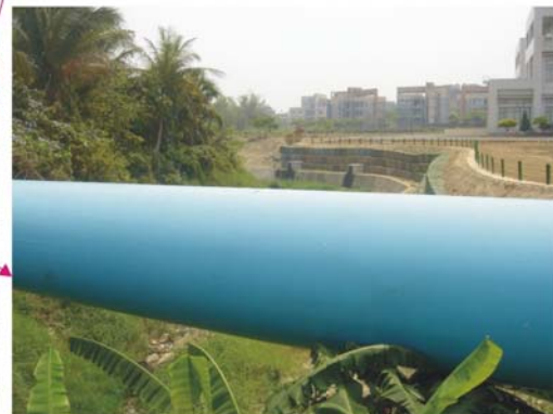
照片3-22 春雨橋上游左岸鄰台南醫院，採石籠護岸治理
