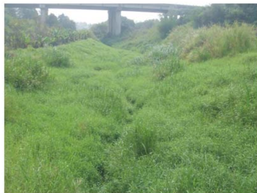
照片3-5 佛顯橋上游河道雜草叢生，已不見水路(照片中高架為國道3號)
