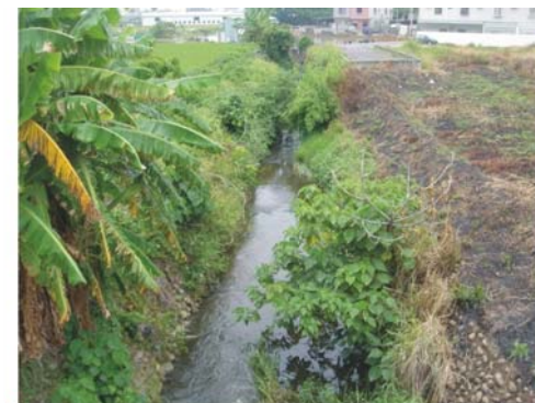
照片3-56 水路橋下游排水路現況
