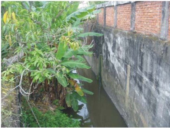
照片3-24 啟聰溝排水多矩形渠道
