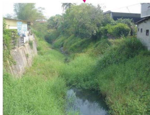
照片3-4 新豐一號橋上游河道內多雜草
