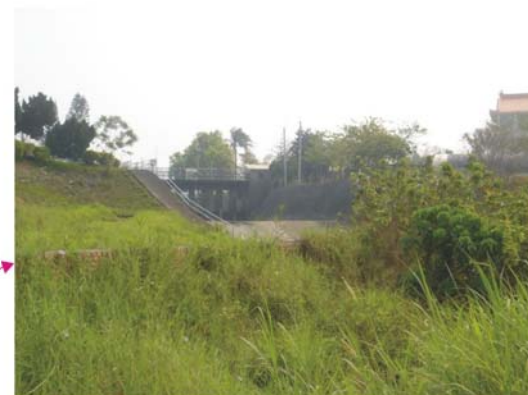
照片3-2 虎頭埤溢洪道出口
