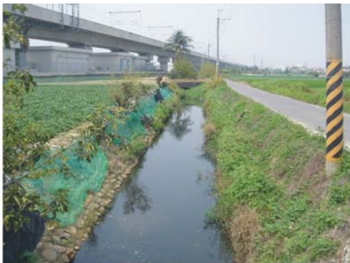
照片3-43 排水路緊貼道路
