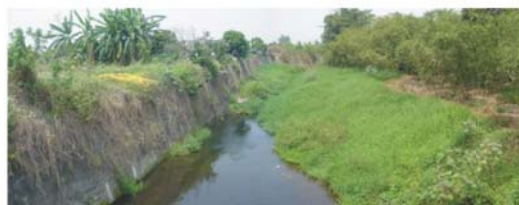
照片3-17 牛稠橋上游右岸為混凝土護岸，左岸為土坡護岸
