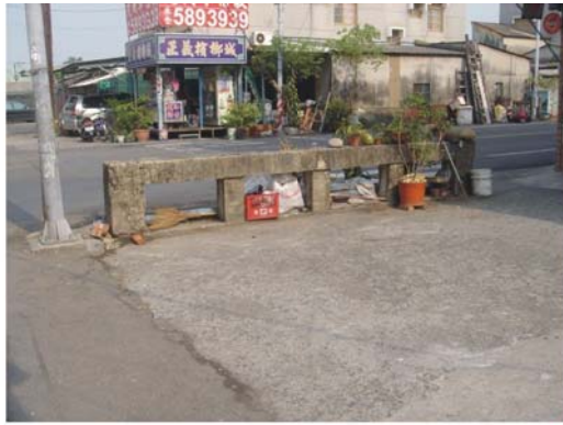
照片3-62 信義路大排加蓋後留下原有橋面護欄
