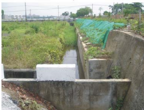
照片3-39 洋子中排二起點 (照片右邊為南幹支線)
