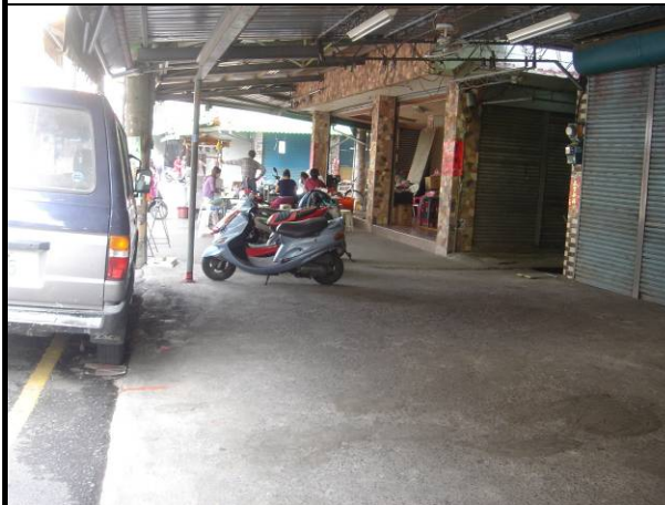
照片 7-3 C 幹線加蓋為住宅騎樓
