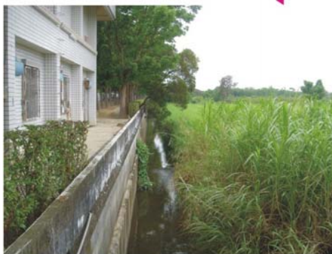
照片3-58 新化鎮體育公園西側之 營尾大排現況情形
