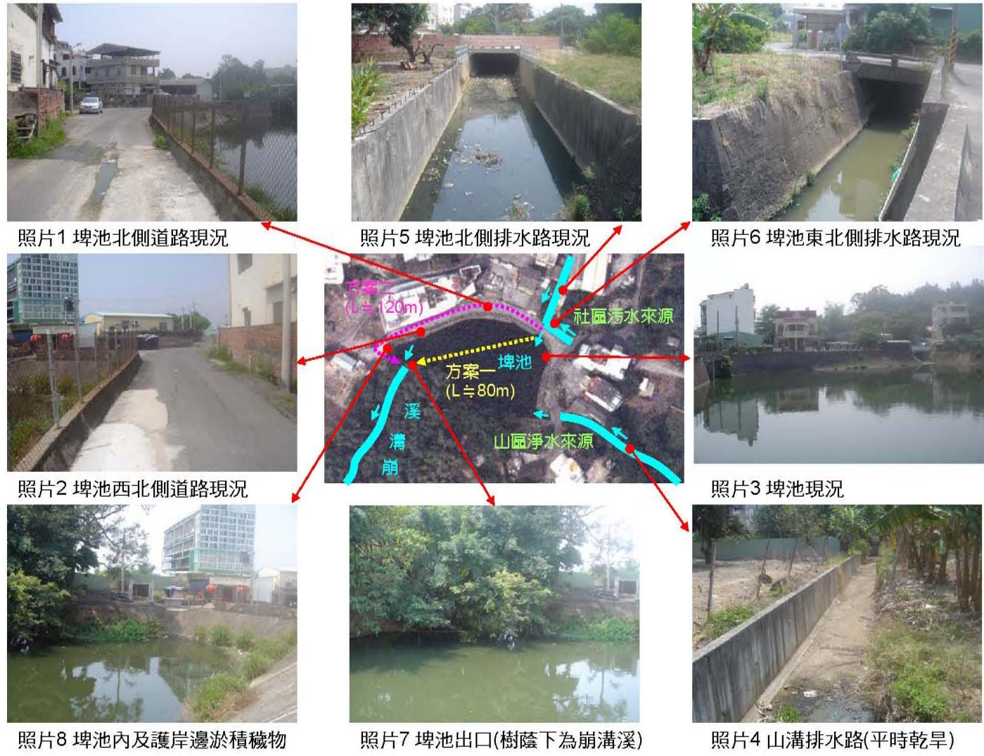
圖 1 崩溝溪排水上游埤池現況照片
