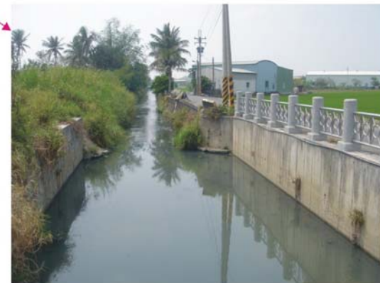
照片3-37 啣口橋下游現況，其上游銜接營尾大排
