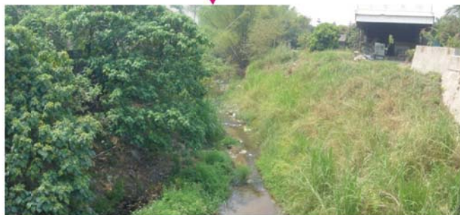
照片3-18 深坑二號橋下游河道現況 (照片中建物為鐵皮工廠)
