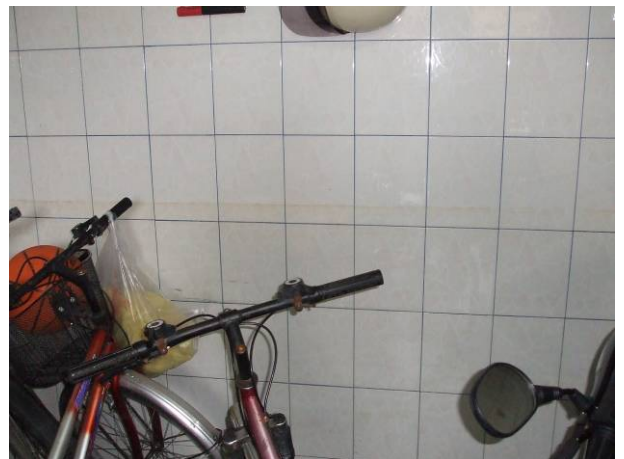
照片 3-74 新豐一號橋附近住宅內，留有淹 水水痕(96. 8. 22 攝)
