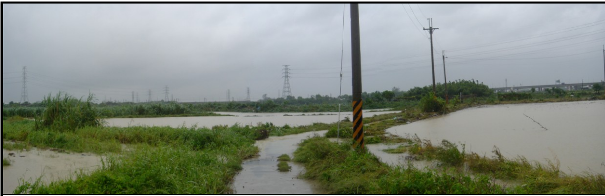
照片 8 卡玫基颱風虎頭溪 0K+231 處之左岸洪氾情形，照片中間為道路，已呈泥濘狀（民國 97 年 7 月 18 日攝）
