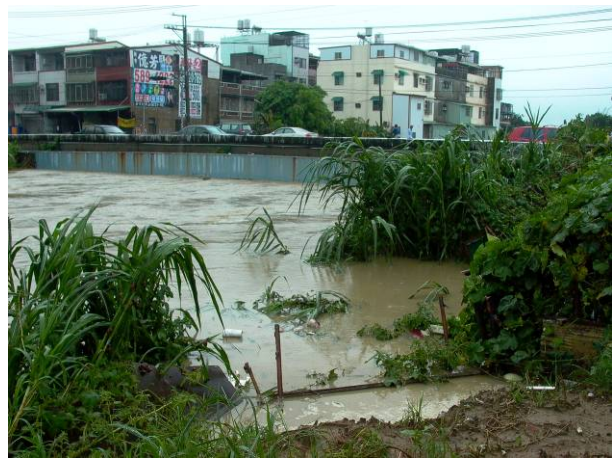
照片 3-71 大目橋處水位高漲淹及橋樑底 (96. 8. 13 攝)
