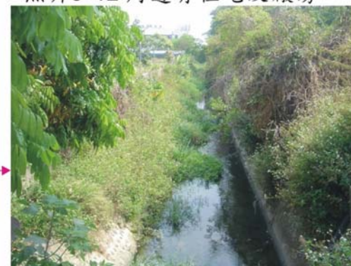
照片3-45 台20線上游現況
