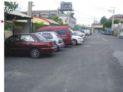
照片3-47 衛生2號排水南144線下游，已被加蓋為停車場
