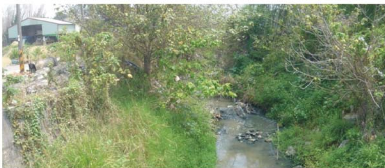
照片3-21 崩溝溪橋上游兩岸多住宅、廠房
