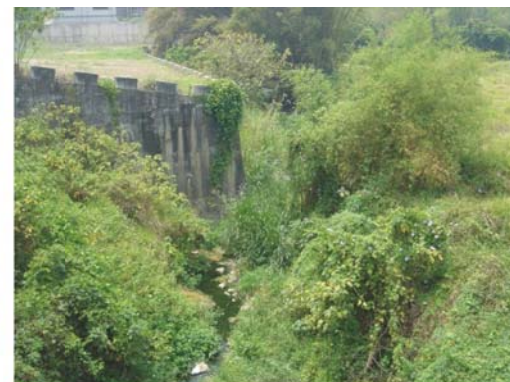
照片3-23 於接天橋俯視河道情形
