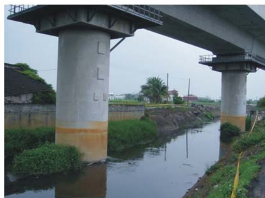
照片3-31 高鐵橋墩落於衛生1號排水
